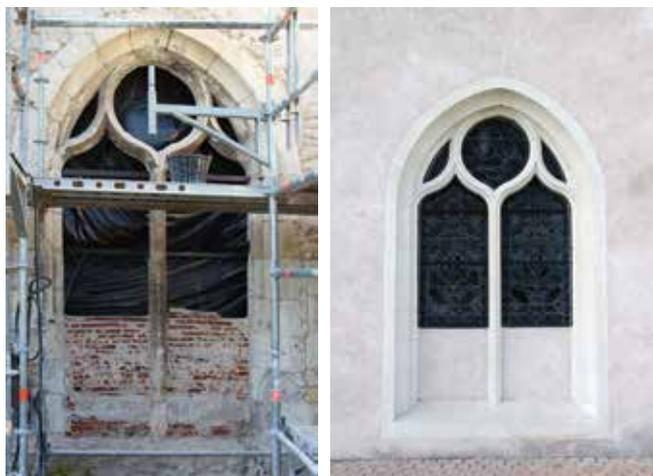
Obturation partielle des fenêtres sud par des briques, avant et après enduit.
